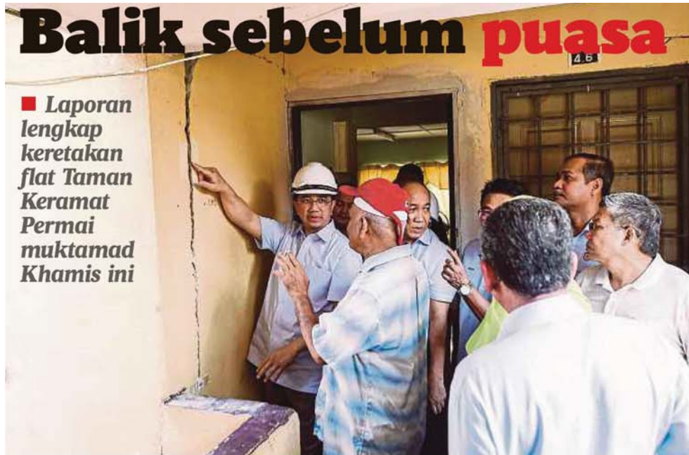
AZMIN meninjau keretakan di Pangsapuri Taman Keramat Permai, semalam.
